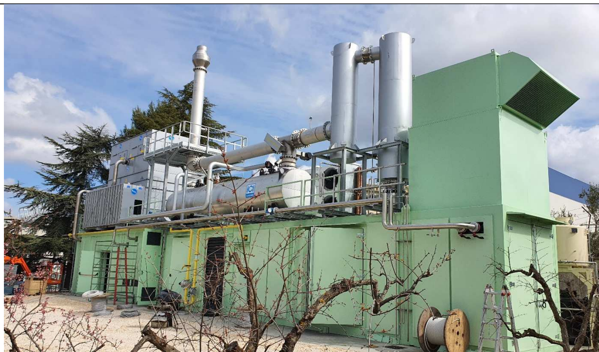
Figura 20 – Impianto di Cogenerazione in fase di installazione presso il Pastificio Granoro
