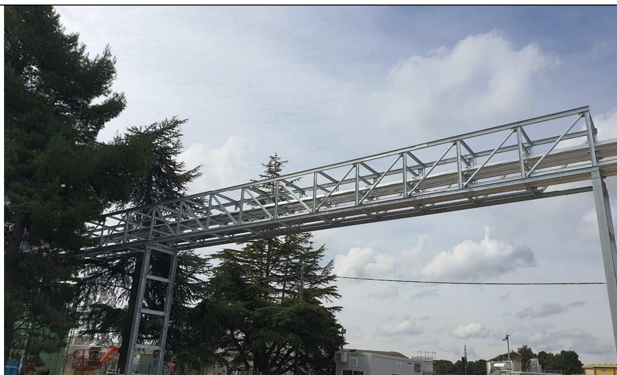
Figura 21 – Pipe Rack per il trasporto delle energie generate dal Cogeneratore verso l'interno dell'opificio
