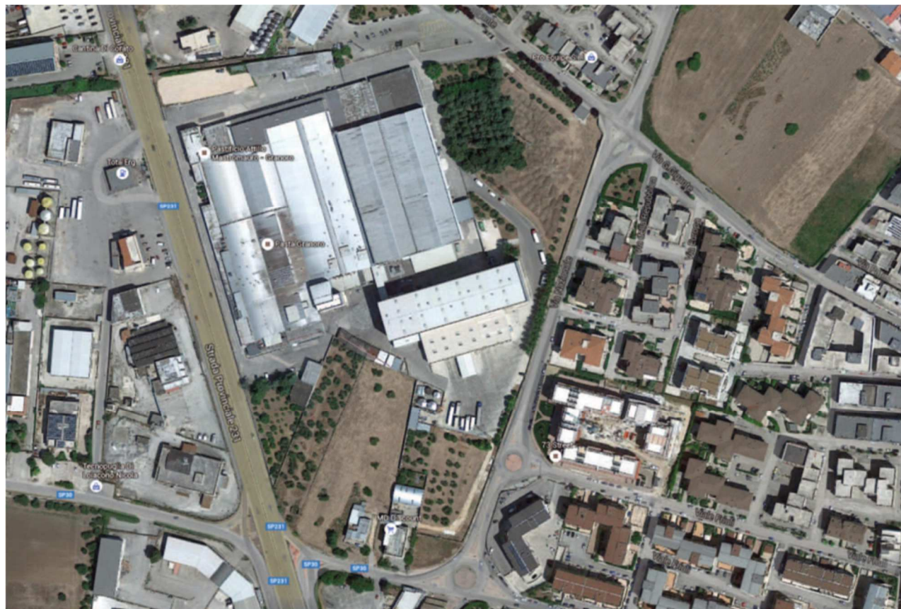
Figura 3 – Foto aerea del sito industriale Granoro
